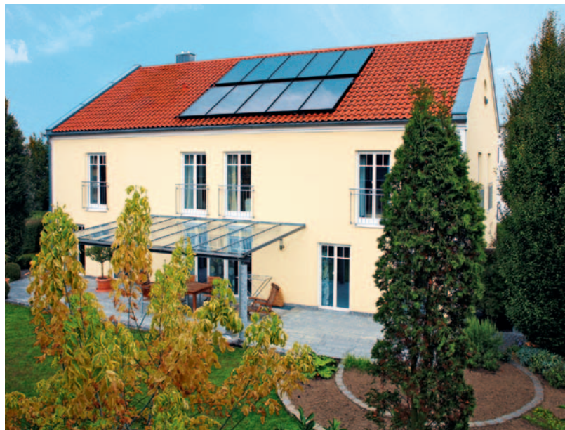
il. 3.10: Kolektor płaski Vitosol 300-F jest wysokowydajnym kolektorem, który szczególnie nadaje się do solarnego wspomagania ogrzewania budynków.
