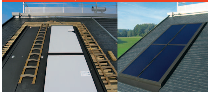
il. 3.19 Zabudowa kolektorów w połaci dachu
